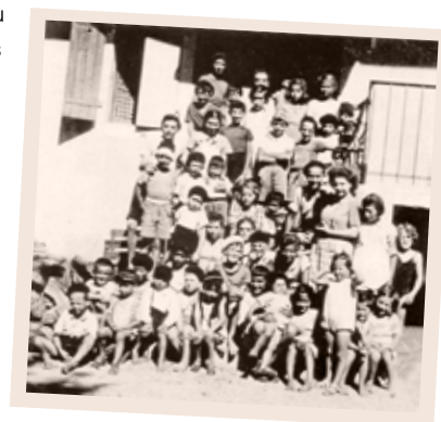
Les enfants et le personnel, été 1943 source photo : Arch. OSE crédit photo : D.R
