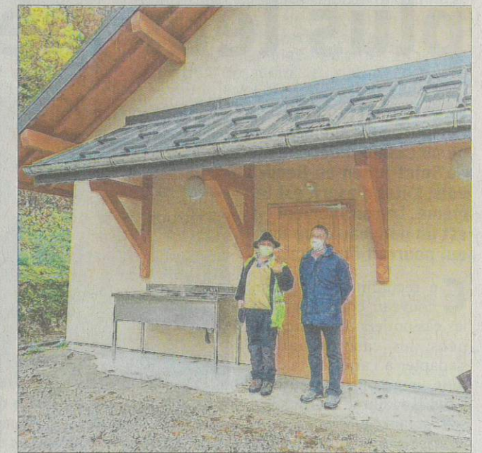
Le maire Jean-François Menoud et l'employé communal Paul Isnard ont fait l'état des lieux du nouveau bâtiment avant de le céder pour location pour l'hiver à la CCHC, qui le met à disposition des saisonniers. Photo Le DL/Chantal BOURREAU
